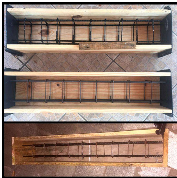
FIGURA 12 – CAIXARIA DAS VIGAS
