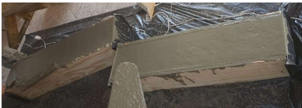
FIGURA 14 – MOLDES ENCHIDOS E PRONTOS PARA INICIAR O PROCESSO DE CURA
